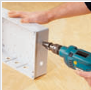
Кабельный ввод может быть просверлен индивидуально.
