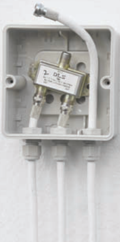
Кабельный ввод может быть просверлен индивидуально.
